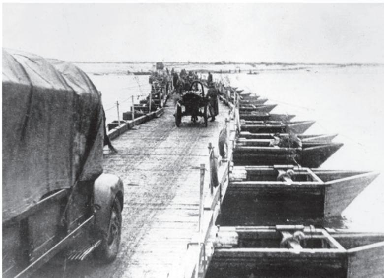
Ил. 2. Наплавной мост из понтонного парка ДМП-42. ВИМАИВиВС
