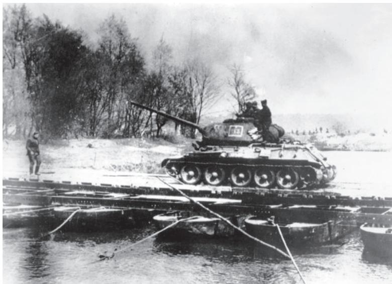
Ил. 3. Наплавной мост из понтонного парка Н2П-41. ВИМАИВиВС
