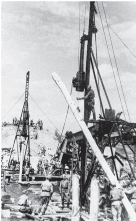
Ил. 4. Забивка свай мостовой ротой 2 ОМЖДБ с применением свайного копра Н. В. Озерова в ходе строительства моста через р. Сунжа
