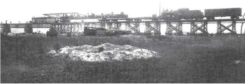
Ил. 3. Надвигка пролётного строения при помощи крана-пилона Н. А. Артеменко на сооружении моста через р. Новый Днепр
